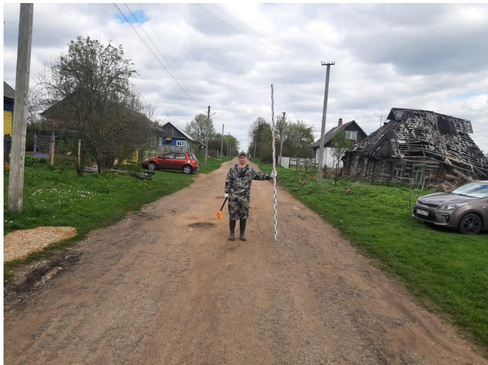
Рис. 22. Участок проведения археологических исследований на объекте: «Уличные газопроводы с. Буднянский Спас-Деменского района». Видовая точка 14. Вид с юго-запада.
