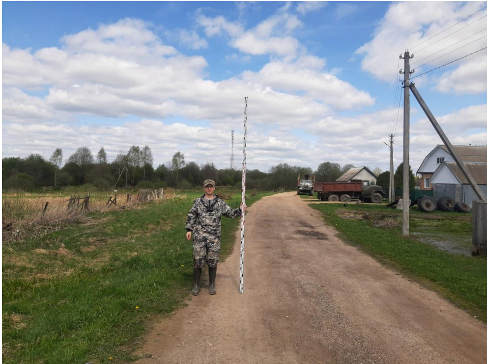
Рис. 13. Участок проведения археологических исследований на объекте: «Уличные газопроводы с. Буднянский Спас-Деменского района». Видовая точка 5. Вид с юга.
